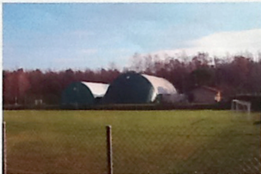
Il centro sportivo di Concagno con i due campi da tennis coperti da tensostruttura
